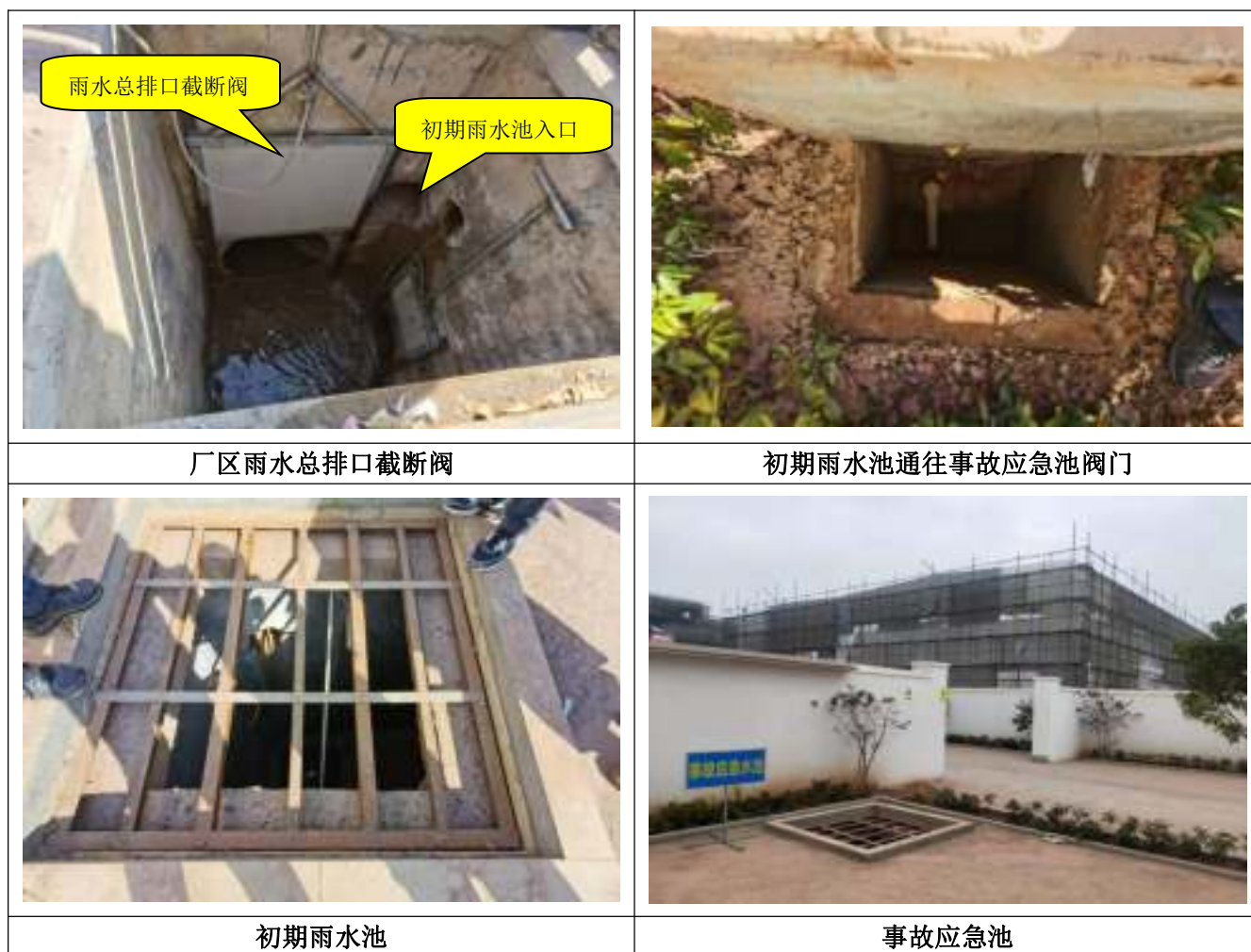
图 2.6-8 雨排水系统现有防控措施
