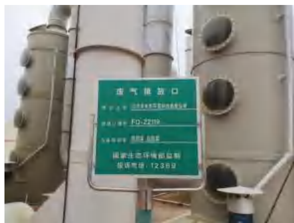
2#吸收塔（三级碱液喷淋）及工艺废气排气筒 P2（FQ-22119）
