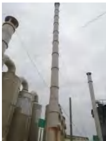
1#吸收塔（二级氯化亚铁+一级碱液喷淋）及工艺废气排气筒 P1（FQ-22117）
