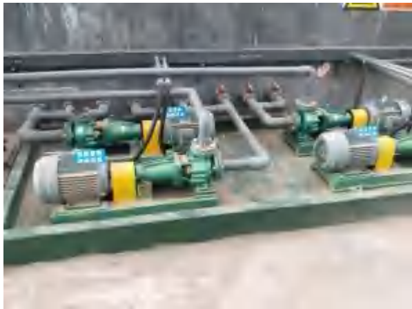
罐区周边卸料平台及物料标签
