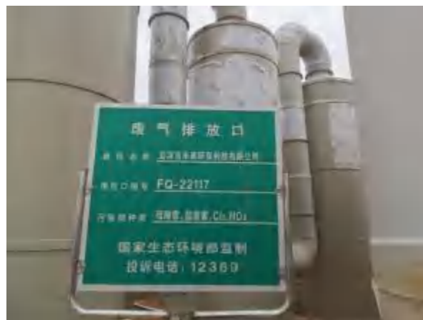
1#吸收塔（二级氯化亚铁+一级碱液喷淋）及工艺废气排气筒 P1（FQ-22117）
