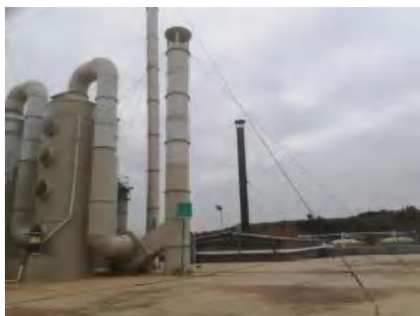
3#吸收塔（三级碱液喷淋）及工艺废气排气筒 P3（FQ-22118）
