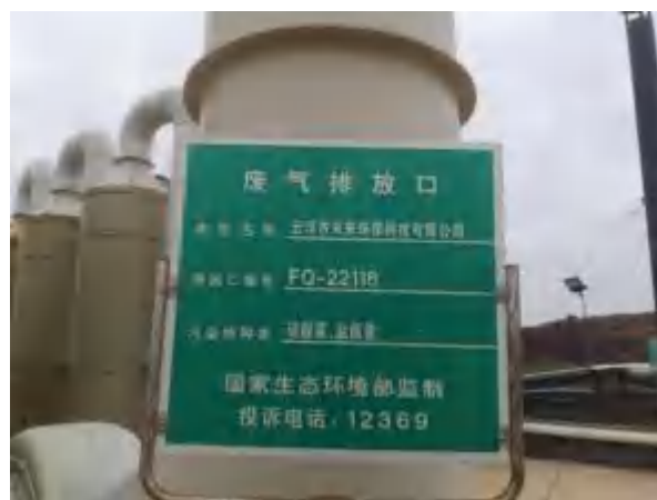
3#吸收塔（三级碱液喷淋）及工艺废气排气筒 P3（FQ-22118）
