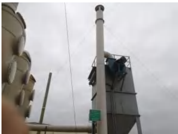
布袋除尘装置及粉尘废气排气筒 P4 (FQ-22120)
