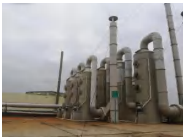
2#吸收塔（三级碱液喷淋）及工艺废气排气筒 P2（FQ-22119）
