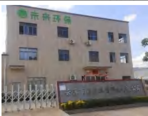
建设项目调试时间公示 (远照)
